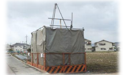
西船橋地区 土質調査状況
