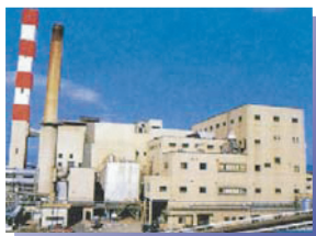
穂谷川清掃工場
