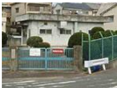
長尾家具町汚水中継ポンプ場(長尾家具町4丁目)
