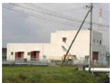
出口汚水中継ポンプ場(出口6丁目)
