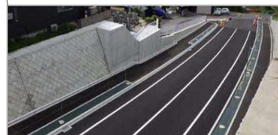
中振交野線 （車道：排水性舗装 歩道：透水性舗装）
