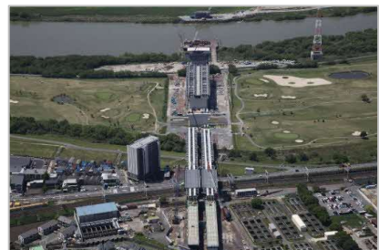
新名神高速道路整備状況 開通予定令和9年度 (出典：NEXCO 西日本 HP)
