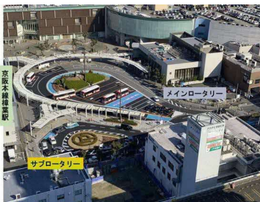
樟葉駅前広場ロータリー改良（令和4年完了） 交通混雑解消や安全性確保のために、 バス・タクシーと一般車両の動線を分離
