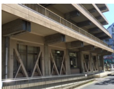
防災拠点としての耐震性の不足
