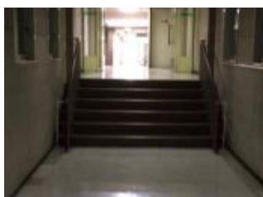
障壁となっている渡り廊下
