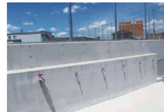
▲春日受水場（応急給水拠点として整備）の応急給水栓
