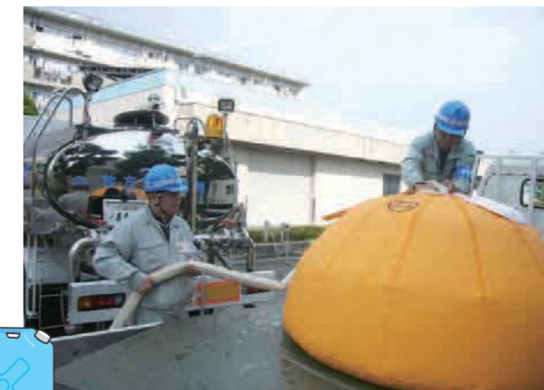
▲給水バルーンへの給水の様子
