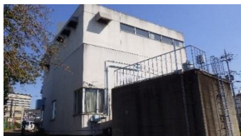
安居川ポンプ場 (三矢町6-4)
