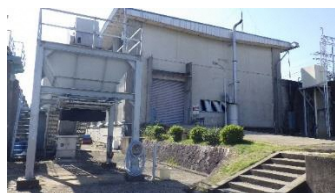
北部ポンプ場 (西船橋2丁目3-1)
