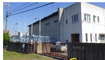
溝谷川ポンプ場 (宮之阪1丁目3-7)
