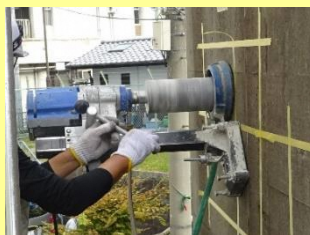
コア抜き作業の様子
