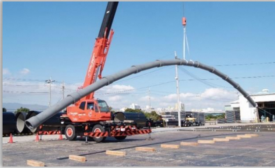
(写真提供：一般財団法人日本ダクタイル鉄管協会)
