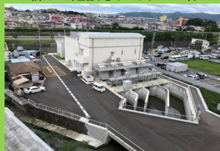
新安居川ポンプ場 新しく建設されたポンプ棟
