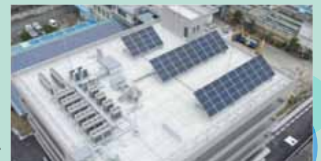
管理棟屋上の太陽光発電設備
