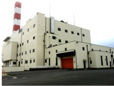
穂谷川清掃工場
