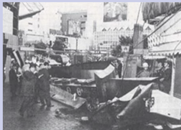
台風で落下した時の様子
