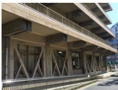
防災拠点としての耐震性の不足
