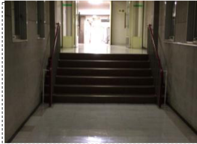
障壁となっている渡り廊下
