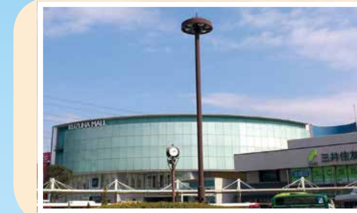
樟葉駅前ロータリーの照明塔。
