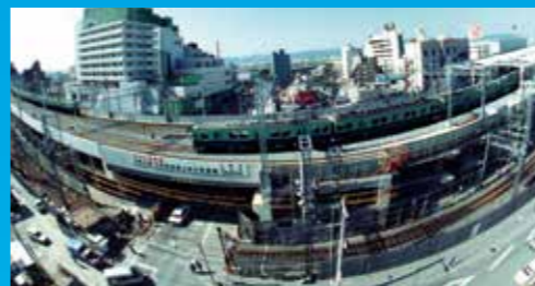
▲高架化工事中の枚方市駅 (平成2年3月)
