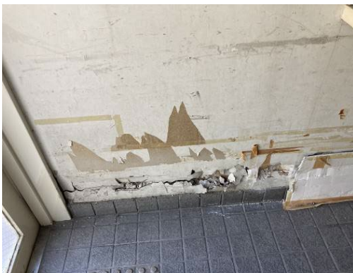
【1階通路下部の壁面崩れ】
