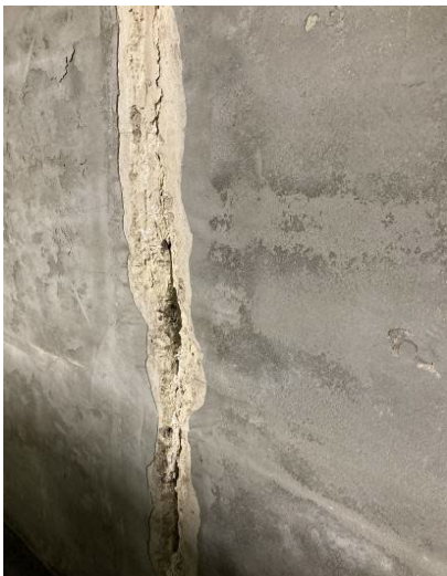
【1階通路下部の壁面崩れ】
