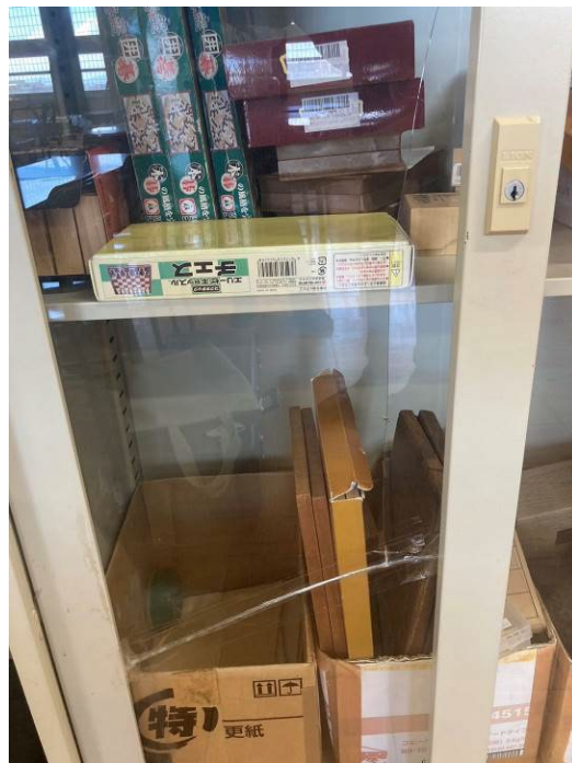
【蹉跎中学校 理科室棚の割れたガラスへのテープの貼り付け】
