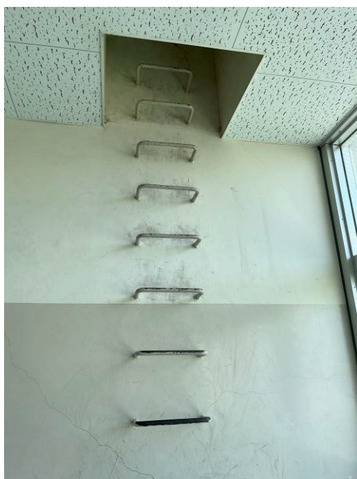
【交北小学校 屋上までの梯子①】
