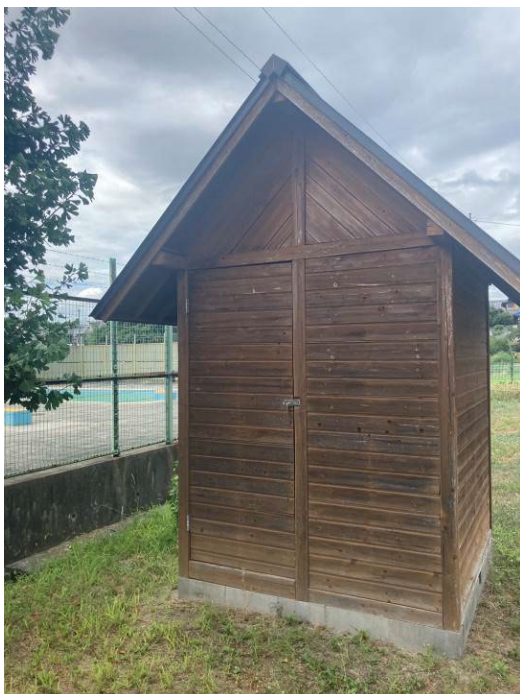
【藤阪小学校 倉庫①】
