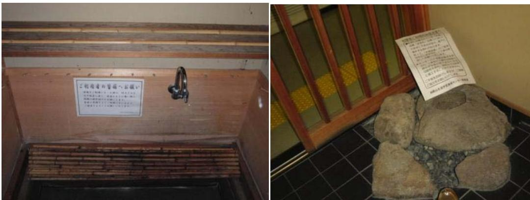
写真左施設の排水管の詰りにより、写真左、右、両施設の床下に排水が滞留することとなっている状況であった。結果としては、建物躯体に大きな損傷を与えることはなかったとのことであるが、現状のまま使用すると階下に水が漏れる可能性があるため、使用禁止にすることで対応しているとのことである。
