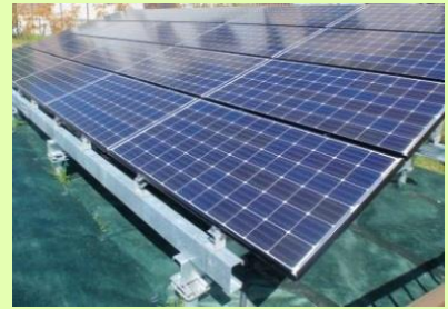
太陽光発電システム
