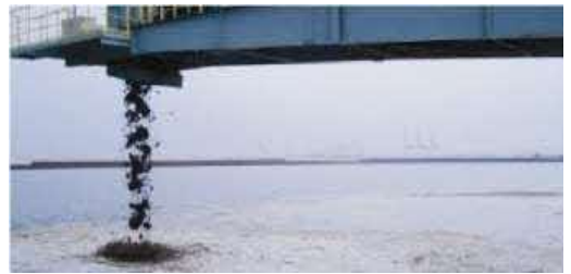
↑ 大阪湾フェニックスセンター
