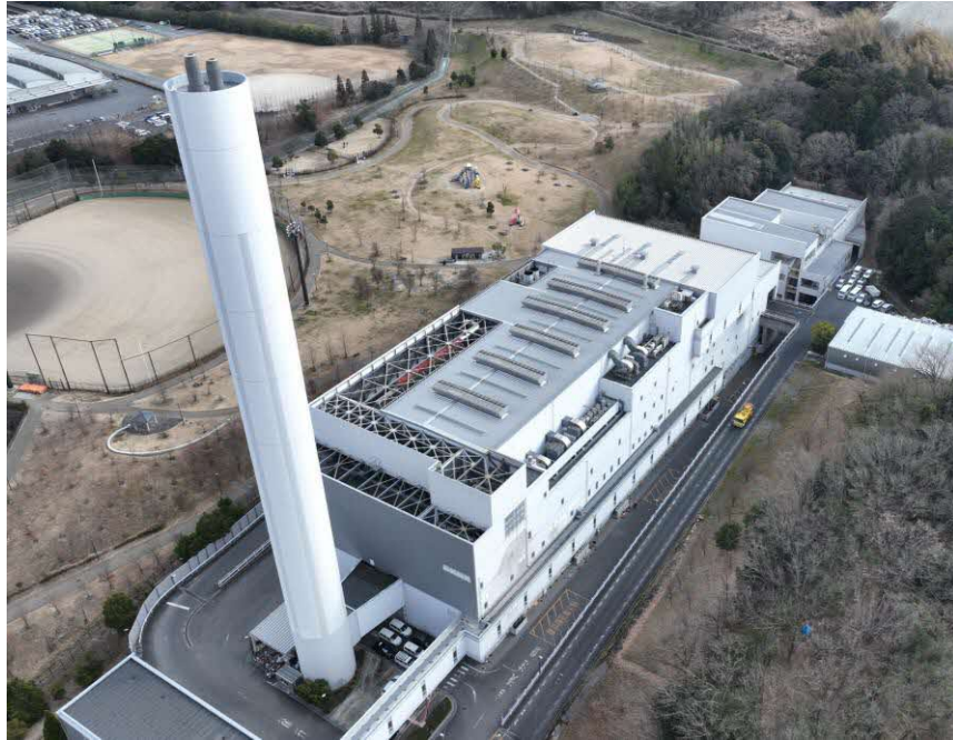
↑ 東部清掃工場の高さ約100mの煙突（写真提供 株式会社ピッコロ社）
