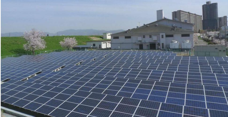
枚方ソラパは、サッカー場くらいの面積に、2,516枚の太陽光パネルがあり、1年間で614,300kWh（約170世帯分）の電力をつくることができます。発電した電気は、みんなのおうちに届けられるほか、枚方市役所の電気自動車の充電などにも利用しています。
