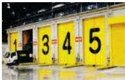
↑ プラットホーム
