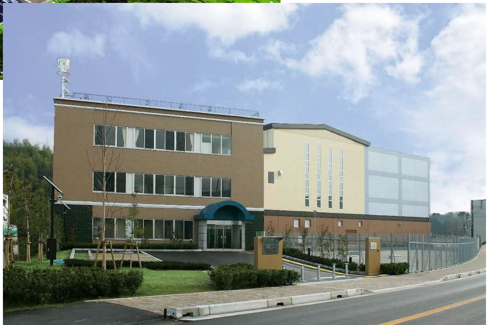
↑ かわち 北河内4市リサイクルプラザ「かざぐるま」（寝屋川市寝屋南1）
