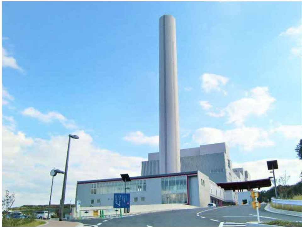
↑ 東部清掃工場の高さ約 100mの煙突
