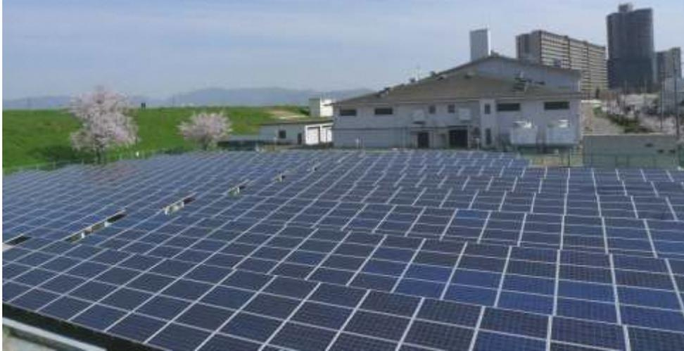
枚方ソラパは、サッカー場くらいの面積に、2,516枚の太陽光パネルがあり、1年間で614,300kWh（約170世帯分）の電力をつくる
