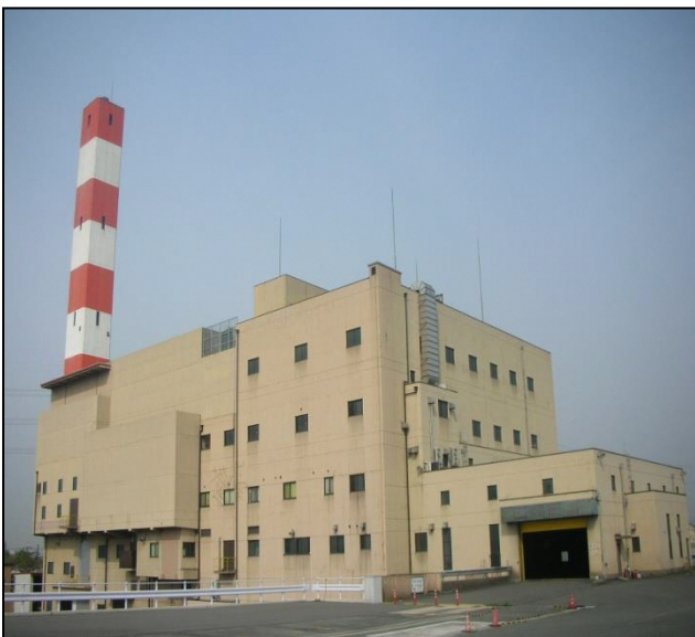
(穂谷川清掃工場)
