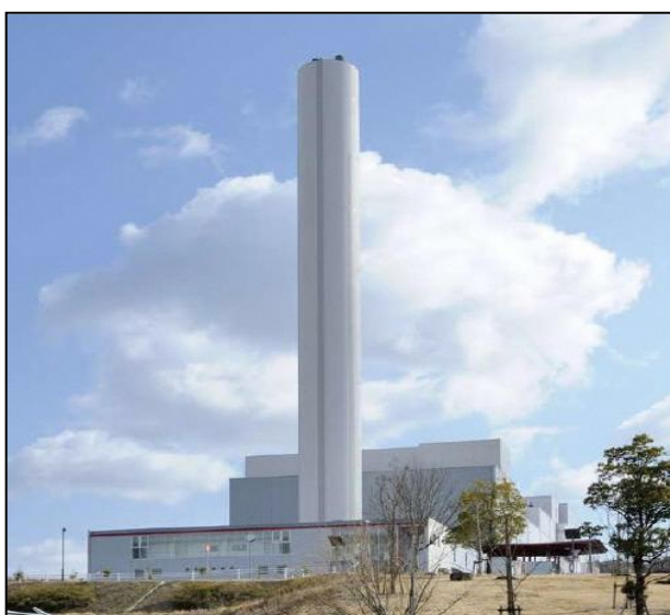
(東部清掃工場 ゴミ焼却施設)
