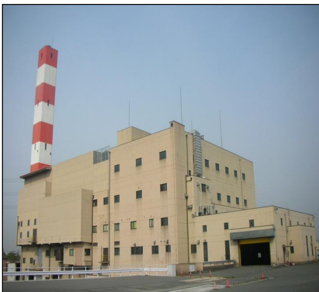
(穂谷川清掃工場)
