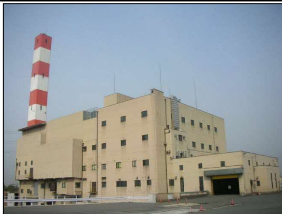
(穂谷川清掃工場)
