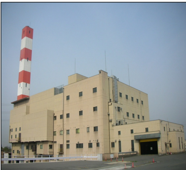
(穂谷川清掃工場)
