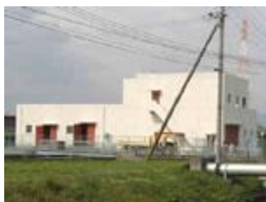
出口汚水中継ポンプ場(出口 6 丁目)
