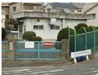
長尾家具町汚水中継ポンプ場(長尾家具町 4 丁目)
