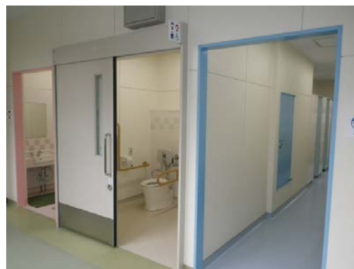
ドライ方式によるトイレ改造
