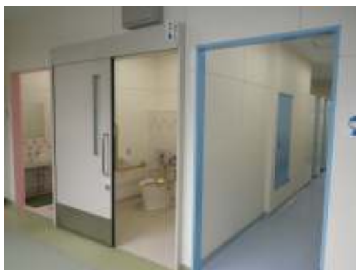
ドライ方式によるトイレ改造
