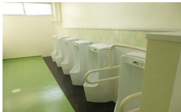
ドライ方式によるトイレ改造（山之上小学校）
