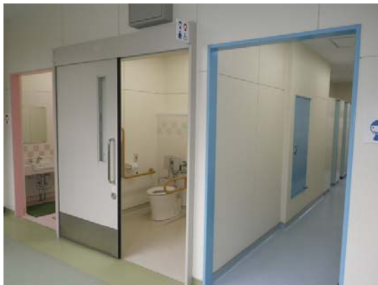
ドライ方式によるトイレ改造（中央は多目的トイレ）
