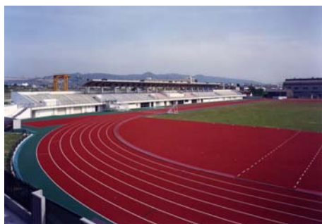
総合スポーツセンター 陸上競技場
