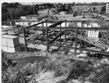
香里ヶ丘図書館建設工事 -平成31年(令和元年)-
