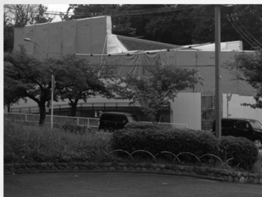
香里ヶ丘図書館解体工事開始 -平成30年4月-
