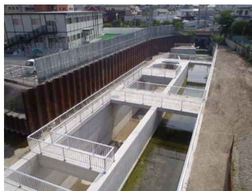
溝谷川ポンプ場
