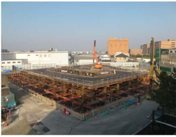
< 春日受水場の更新・耐震化 施工現場 >
