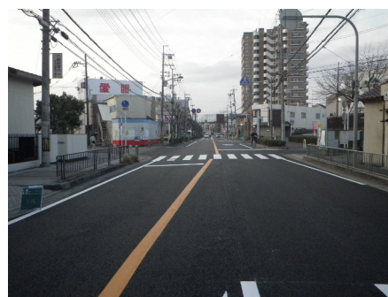
〈整備後の岡東山之上東 1 号線〉
