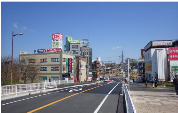
枚方藤阪線（天津橋工区）完成区間
