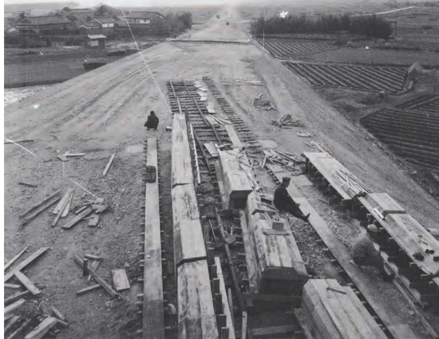
▲建設中の枚方バイパス（昭和37年）。現在の穂谷川新橋から大阪方面の出屋敷交差点付近を望んでいます。
