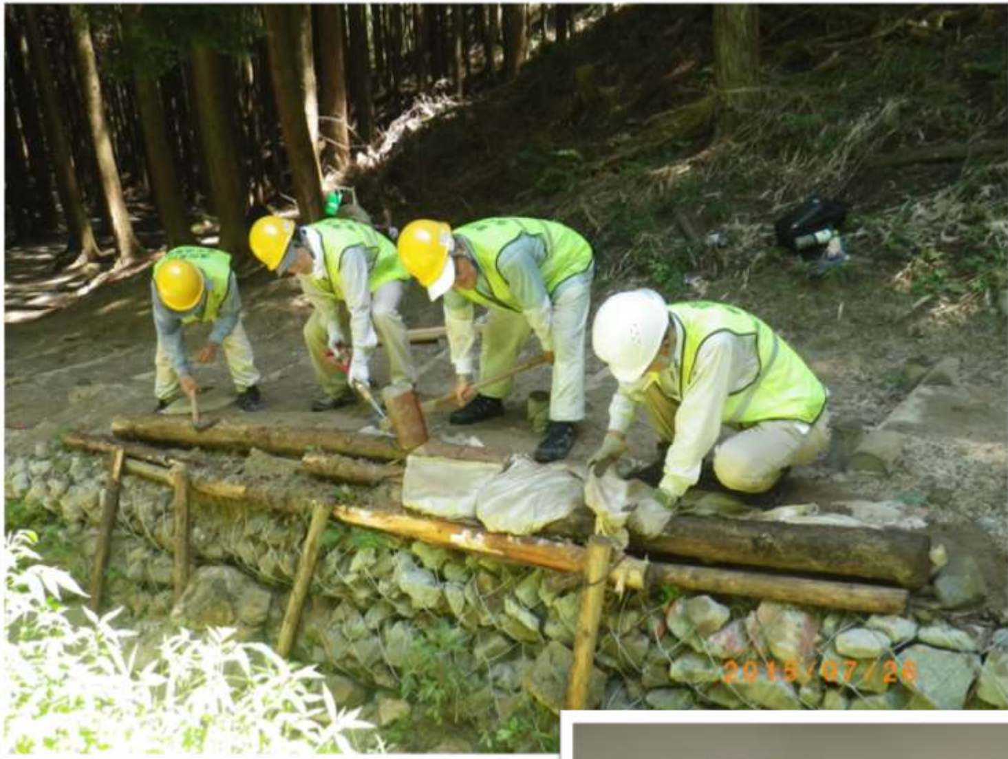
崩壊した 箇所への補修
