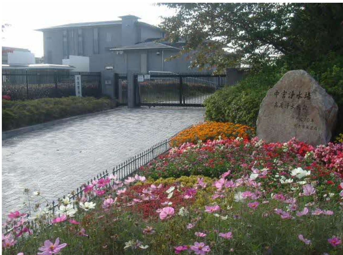
(写真) 中宮浄水場高度浄水施設
