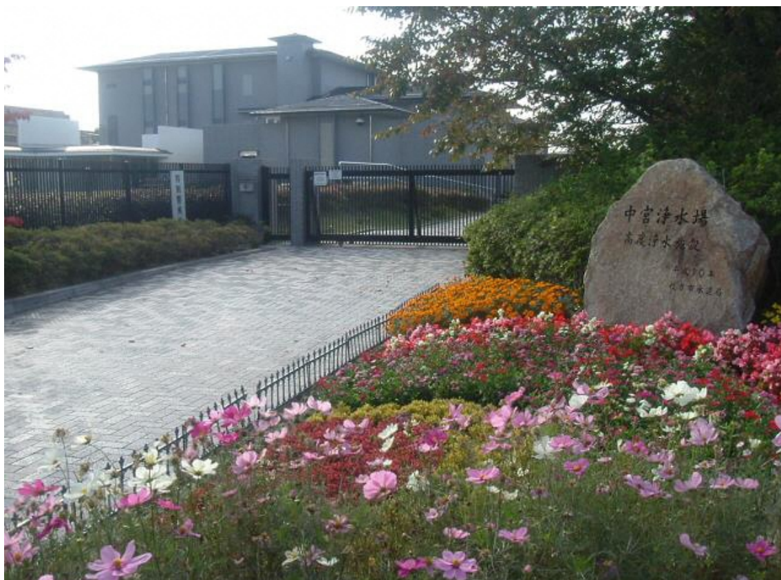
(写真) 中宮浄水場高度浄水施設
