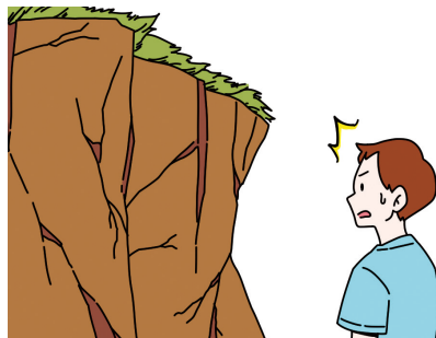
斜面にひび割れができる。
