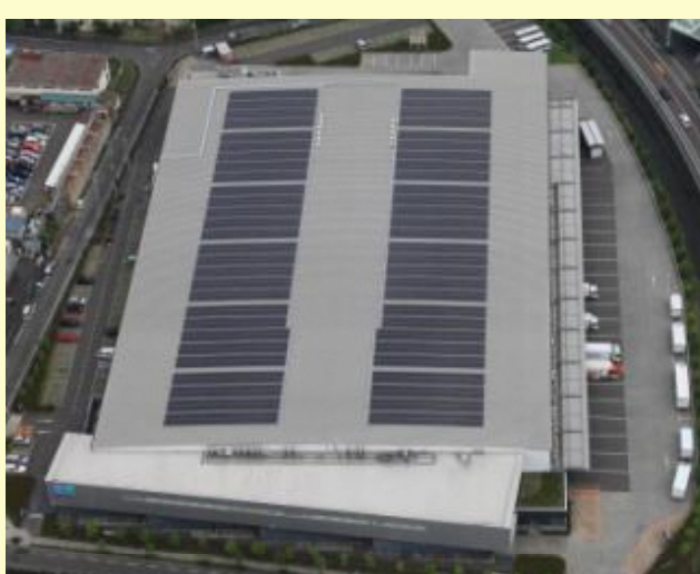
おおさか協同物流センター太陽光発電設備
