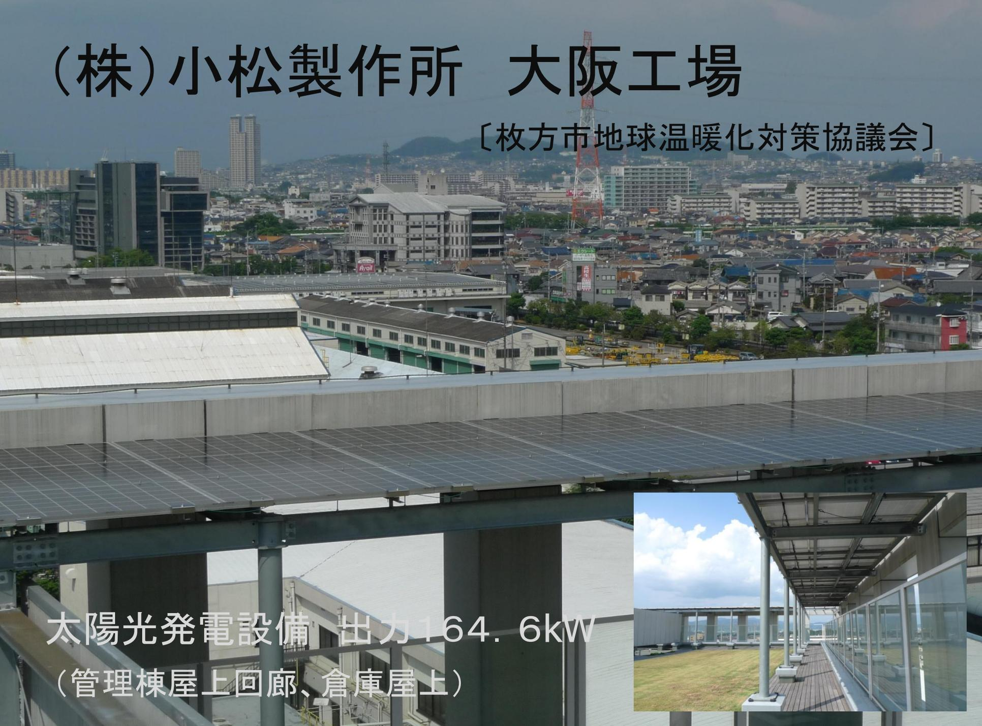
太陽光発電設備 出力164.6kW
