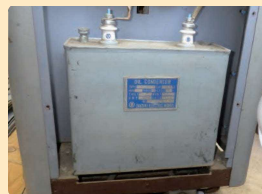
配電盤内の 低圧コンデンサー
