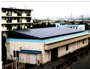
中宮浄水場 (40kW)
