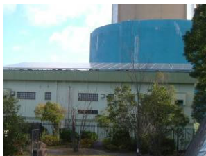
北山配水場 (20kW)
