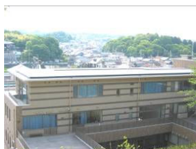
南部生涯学習市民センター (20kW)
