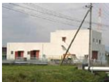
出口汚水中継ポンプ場(出口6丁目)
