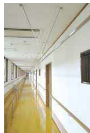
●廊下の盲導線(天井)
